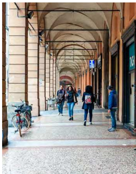
Fig. 41. Pavimentazione alla Veneziana con motivi a fasce, Ph. Nicola La Terra.
