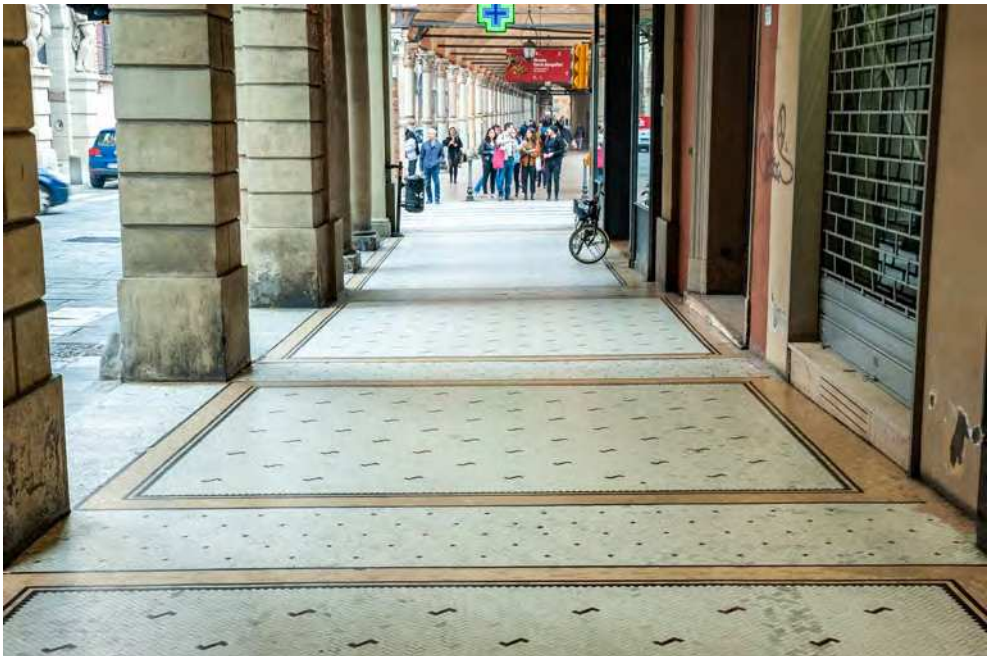
Fig. 43. Pavimentazione alla Veneziana con motivi a fasce, Ph. Nicola La Terra.
