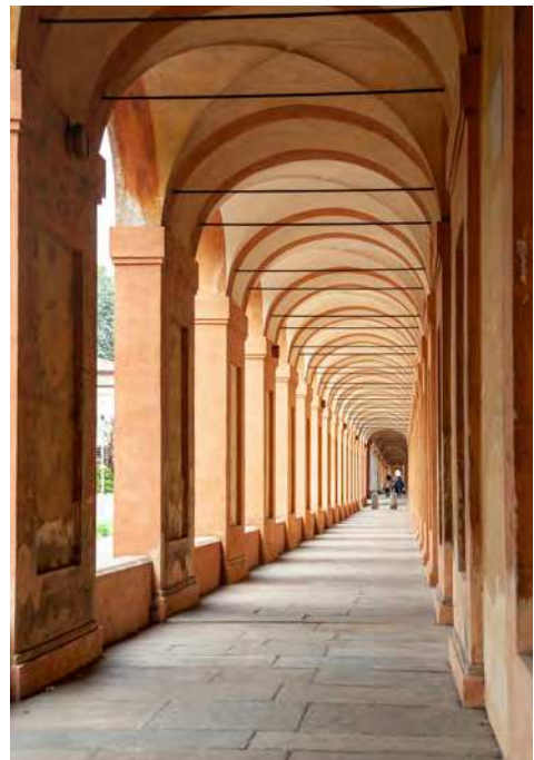
Fig. 34. Pavimentazione portico di San Luca in pietre di Luserna, Ph. Nicola La Terra.
