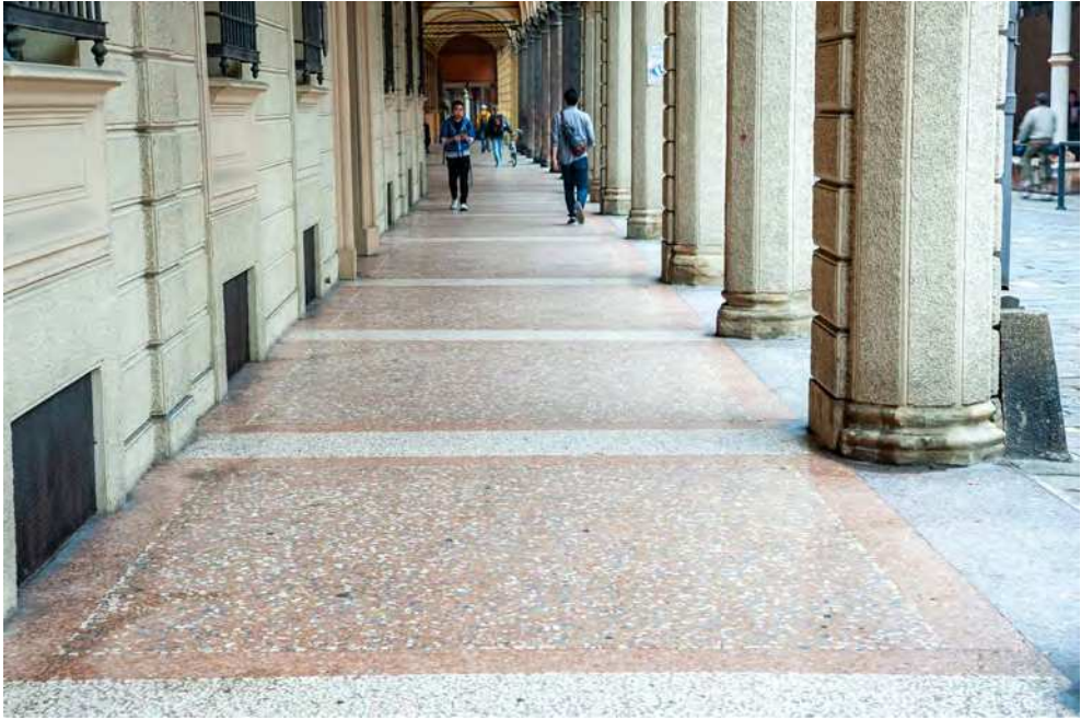
Fig. 42. Pavimentazione alla Veneziana con motivi a fasce, Ph. Nicola La Terra.
