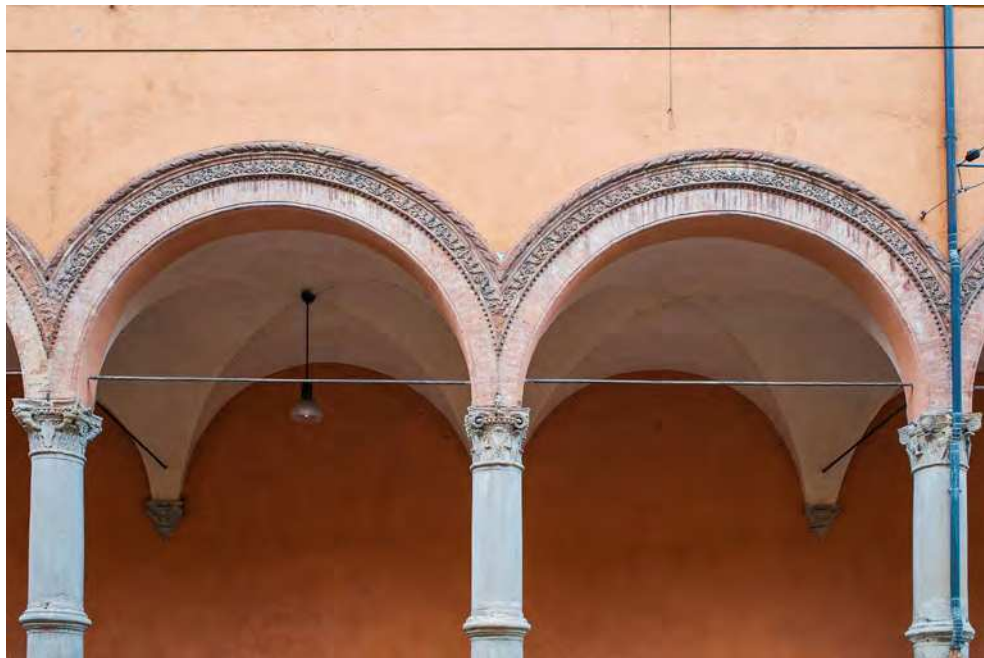
Fig. 29. Particolare Portico del Baraccano, Ph. Nicola La Terra.
