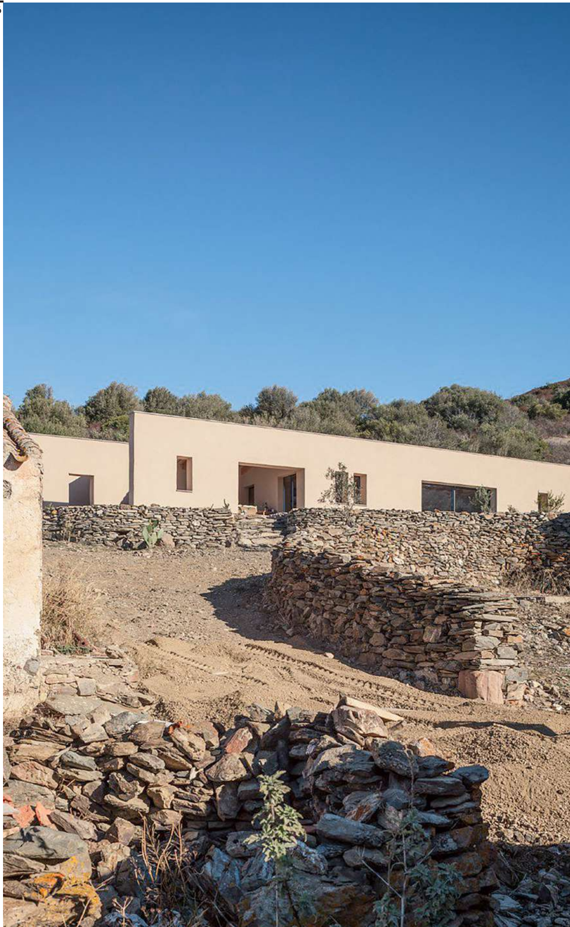
Fig. 6 Pretziada Headquarters. Il progetto prevede la riqualificazione di tre edifici rurali, con l'aggiunta di un nuovo volume nel furriadroxiu (casa- fattoria) di Is Aresus, M. Casciu, F. Rango, 2015-2017, Santadi, Sud Sardegna (foto S. Ferrando, Studio Vetro Blu).
