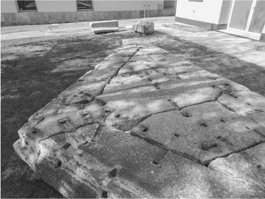
3. Dettaglio della parte centrale della pavimentazione. © Milano, Archivio Museo Nazionale della Scienza e della Tecnologia
