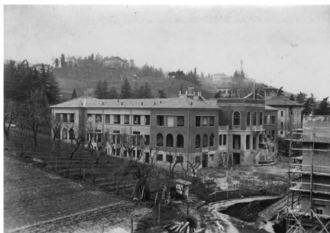
Figura 7. Edificio in costruzione, fotografia scattata il 30 marzo 1934 (su concessione dell'Alma Mater Studiorum-Università di Bologna, Biblioteca Universitaria di Bologna-Archivio storico, Fondo fotografico, Edilizia universitaria (positivi), Facoltà di Chimica Industriale, Cantieri, foto 005).
