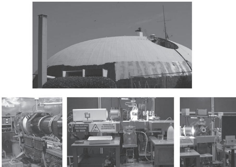
Figura 3. La cupola costruita appositamente per ospitare un acceleratore di elettroni da 12 MeV e parti dell'acceleratore.
