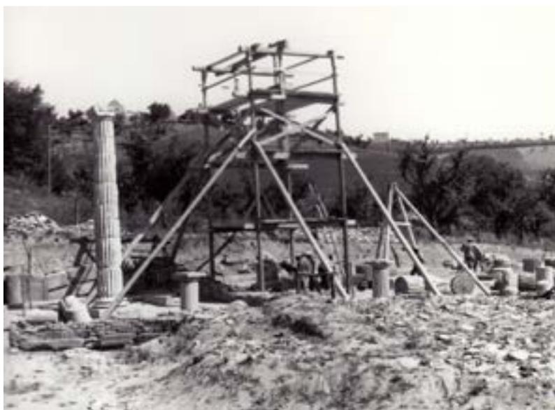
*Fig. 22.* Il ponteggio per l'anastilosi del portico (A.SABAP-M.).
