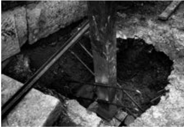
*Fig. 26.* Scavo per l'alloggiamento dei sostegni della copertura moderna (A.SABAP-M.).
