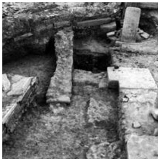
Fig. 71. Le basi del colonnato dorico con le fondazioni che insistono su una massicciata di malta (A.SABAP-M.).
