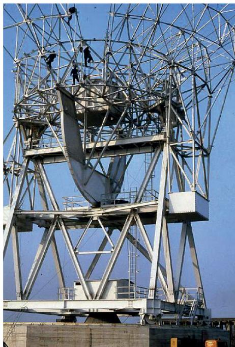
**Figura 5.1** Montatori al lavoro nel 1982 per completare la struttura di supporto dello specchio primario dell'antenna parabolica di 32 m di diametro presso la stazione radioastronomica di Medicina. Crediti: INAF-IRA.
