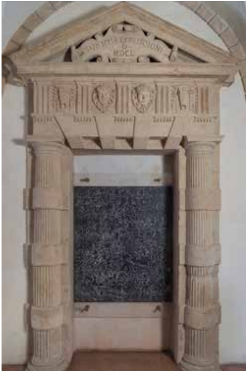
Portale dorico nel corridoio al pianterreno
